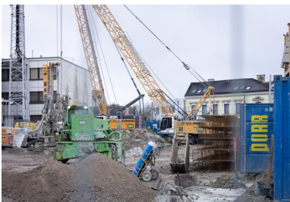
Die Bauzeit des MIA beträgt 36 Monate © Angelika Zobel
