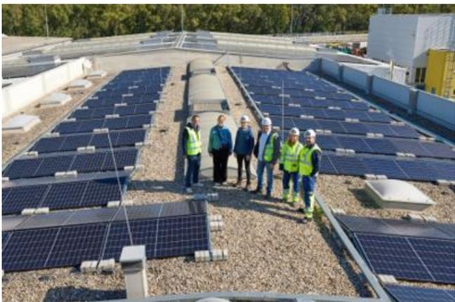
*Die Anlage in Wien-Simmering umfasst 900 Module und eine Leistung von 414 kWp © Oberbrammerger*
