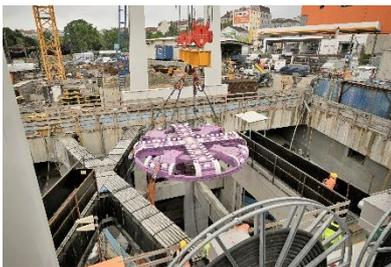
*Der Einhub des Schneirads, das Prunkstück der TVM, beim Matzleinsdorfer Platz. Es wiegt ca. 78 Tonnen, hat einen Durchmesser von 6,88 Meter und ist mit etwa 40 Rollmeisseln und 100 Schälmessern bestückt. © ARGE U2 17-21*
