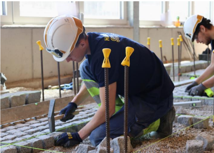
Im Tiefbau wurde gepflastert © PORR
