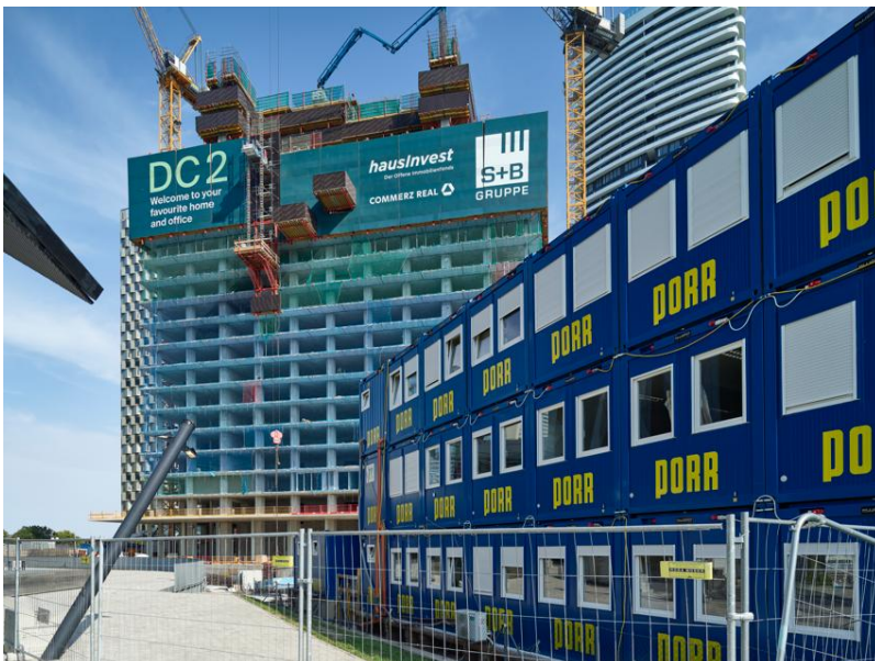
Foto 2: PORR building the DC Tower 2 © MW Architekturfotografie
