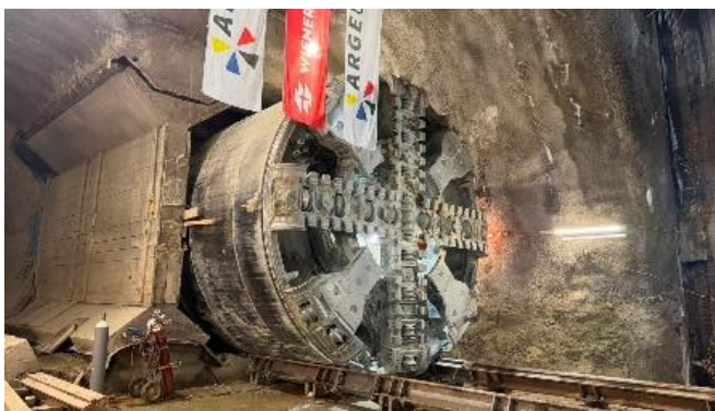
Durchschlag der TVM „Debohra“ am Augustinplatz © ARGE U2 17-21
