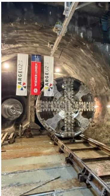
Durchschlag der TVM „Debohra“ am Augustinplatz inkl. Blick auf Gleis 2 © ARGE U2 17-21
