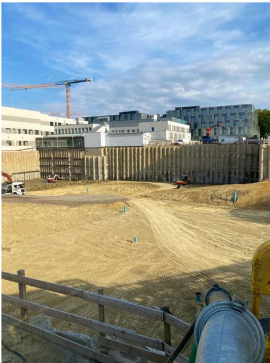
10.500 m 2 -große Baugrube der Zentralen Notaufnahme der Klinik Favoriten © PORR
