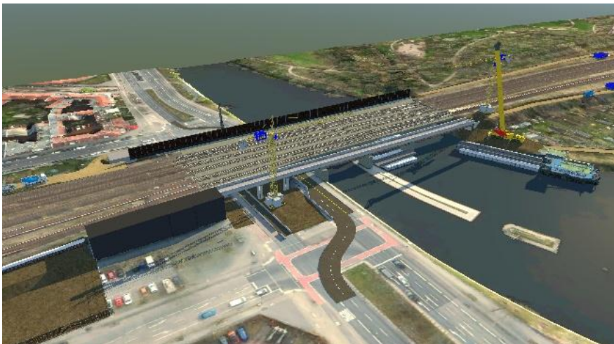
Die Arbeiten an denkmalgeschützten Bestandsbauwerken und entlang bestehender Gleisanlagen erfordern exakte Logistik und Koordination © DB InfraGO AG
