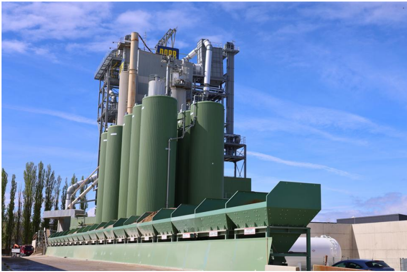
Asphaltmischanlage der PORR in Wien Simmering © PORR
